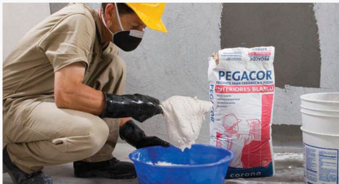
Figura 8-15: Consistencia óptima de preparación de un adhesivo de la familia Pegacor®.
