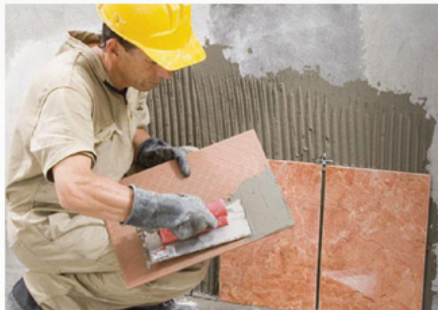
Figura 8-9: Técnica del doble encolado.
